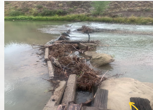
CEDAR DITCH DIVERSION
